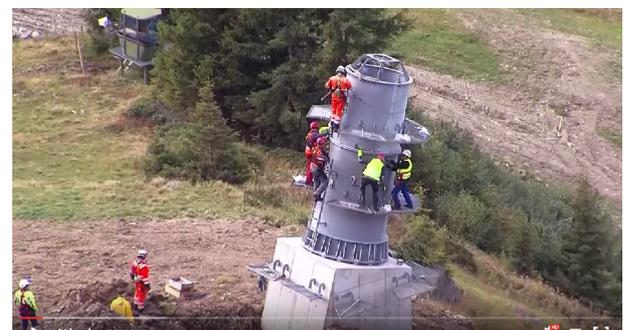
Aufbau eines Stützenfundaments
