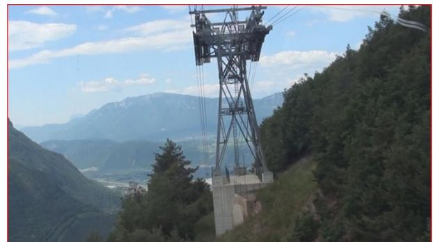
Stütze mit Betonfundament in Bozen
